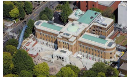
日本館航空写真
