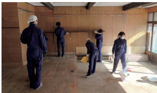
空き家の状況を調査
