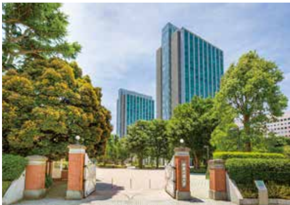
現在の津田沼校舎に残る赤煉瓦門(通用門)
