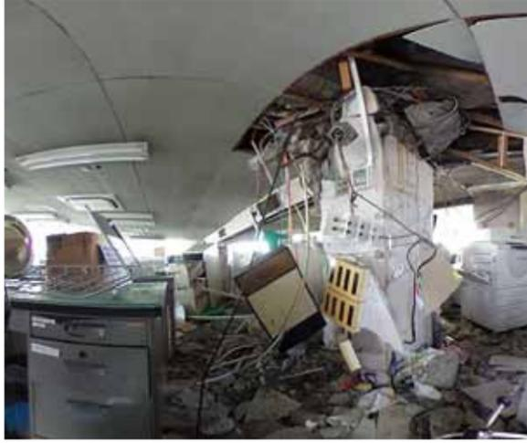
「櫻志號」が捉えた、天井が崩れ落ちた宇土市役所の内部
