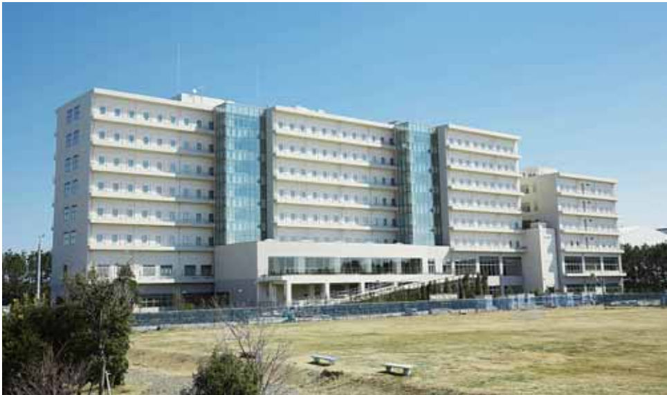
海側から見た新学生寮。左が桑蓬寮、右端の1棟が椿寮
